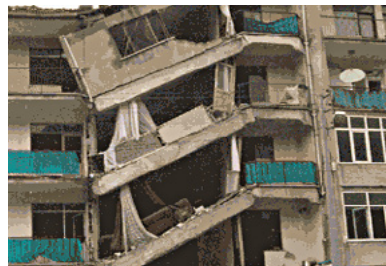
Abb.4: Ausgefallene / überlastete Auflager
