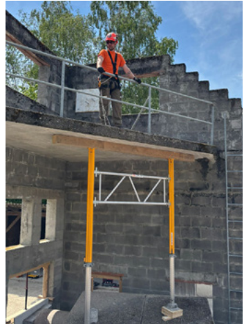
Abb. 55: Senkrechtes Flächenfachwerk mit Systemstützen aus dem Bausektor (BABS)
