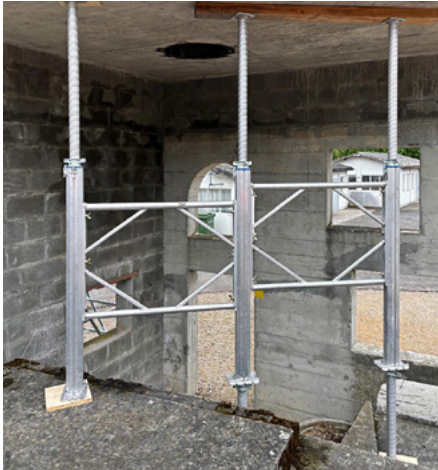
Abb. 55: Senkrechtes Flächenfachwerk mit Systemstützen aus dem Bausektor (BABS)
