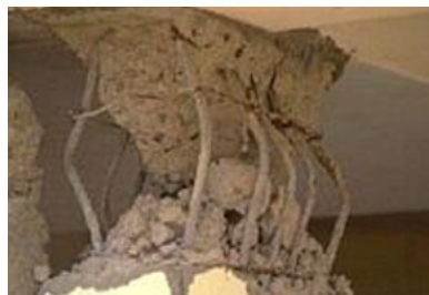
Abb.5: Freiliegende Armierungseisen
