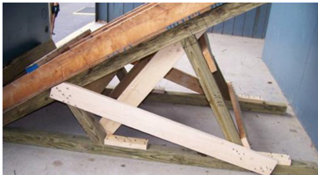
Abb. 92: Schräges Raumfachwerk aus Holz (rechtwinklige Methode) (FEMA)
