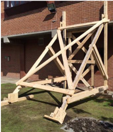
Abb.22: Wandabstützung aus Holz (FEMA)
