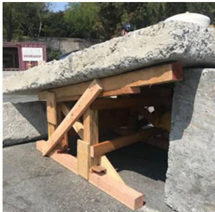
Abb.95: Schräges Raumfachwerk aus Holz (senkrechte Methode) (FEMA)
