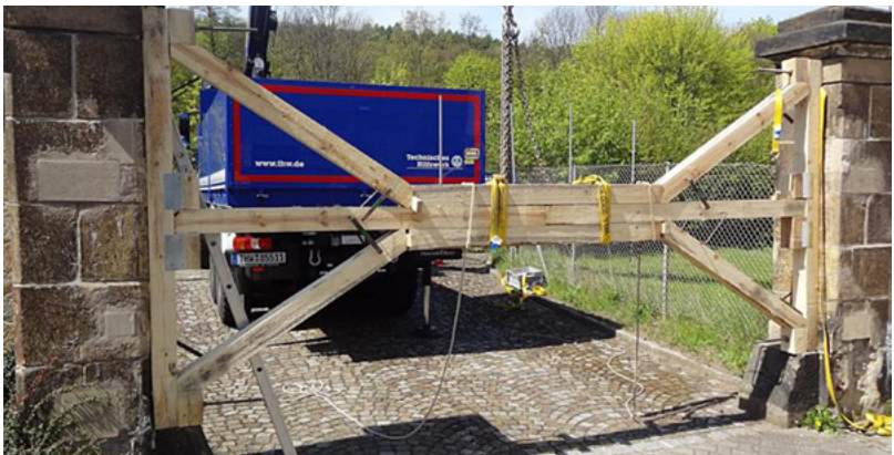
Abb. 79: Beispiel eines Sprengwerks (THW)
