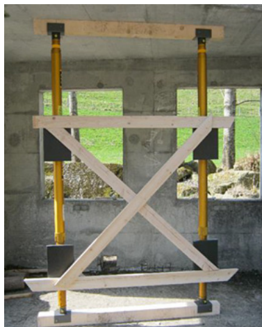
Abb. 56: Senkrechtes Flächenfachwerk mit Systemstützen aus dem Rettungssektor
