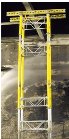
Abb. 60: Senkrechte Raumfachwerke aus Systemstützen und aus Gerüstbaumaterial
