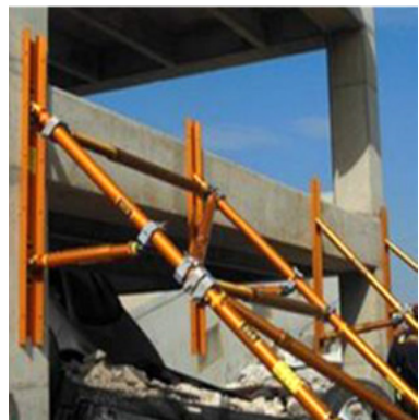
Abb.106: Strebstützen mit Systemstützen aus dem Rettungssektor
