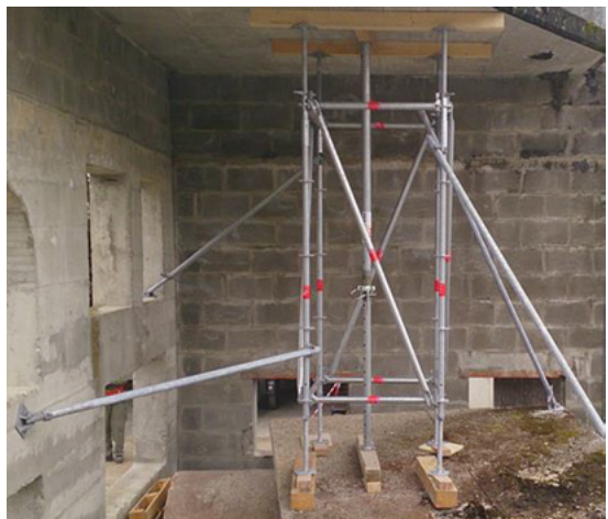
Abb. 60: Senkrechte Raumfachwerke aus Systemstützen und aus Gerüstbaumaterial
