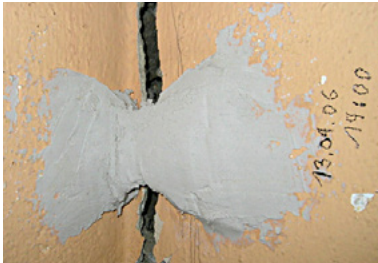
Abb.18: Gipsiegel über einem Riss
