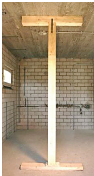
Abb.45: Senkrechte Holzstütze (Blockhaus, THW)
