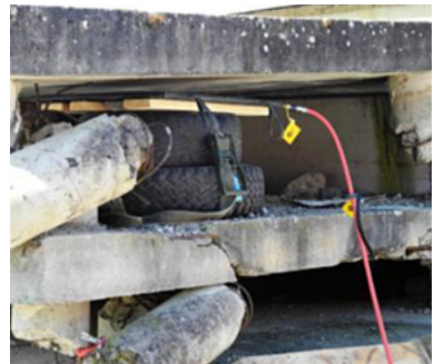
Abb. 115: Beispiel alternative Abstützung: Mit Steinen gefüllte Pneus, gegen seitliche Verschiebung mit Zurrband gesichert und mit Hebekissen kraftschlüssig eingespannt (Rettungskette Schweiz)
