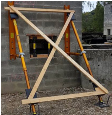
Abb.106: Strebstützen mit Systemstützen aus dem Rettungssektor
