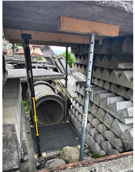
Abb.47: Einzelstütze aus dem Rettungssektor (Paratech)
