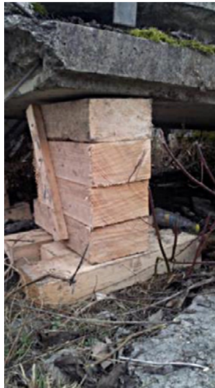
Abb. 74: Beispiele von einfachen Kantholzstapeln (Regina Wenk)
