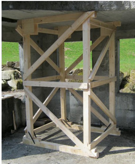
Abb. 59: Beispiel eines senkrechten Raumfachwerks aus Holz
