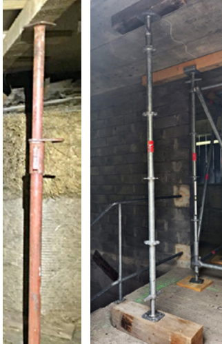
Abb.46: Einzelstützen aus dem Bausektor (Blockhaus, THW)
