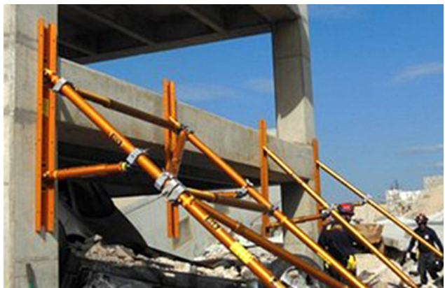
Abb.27: Abstützungen mit multifunktionellen Rettungsstützen (Paratech)
