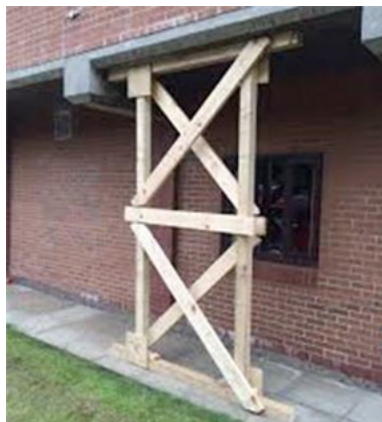
Abb. 54: Beispiel eines senkrechten Flächentragwerks aus Holz (FEMA)
