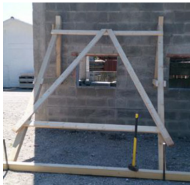
Abb.104: Beispiel Strebstütze aus Holz
